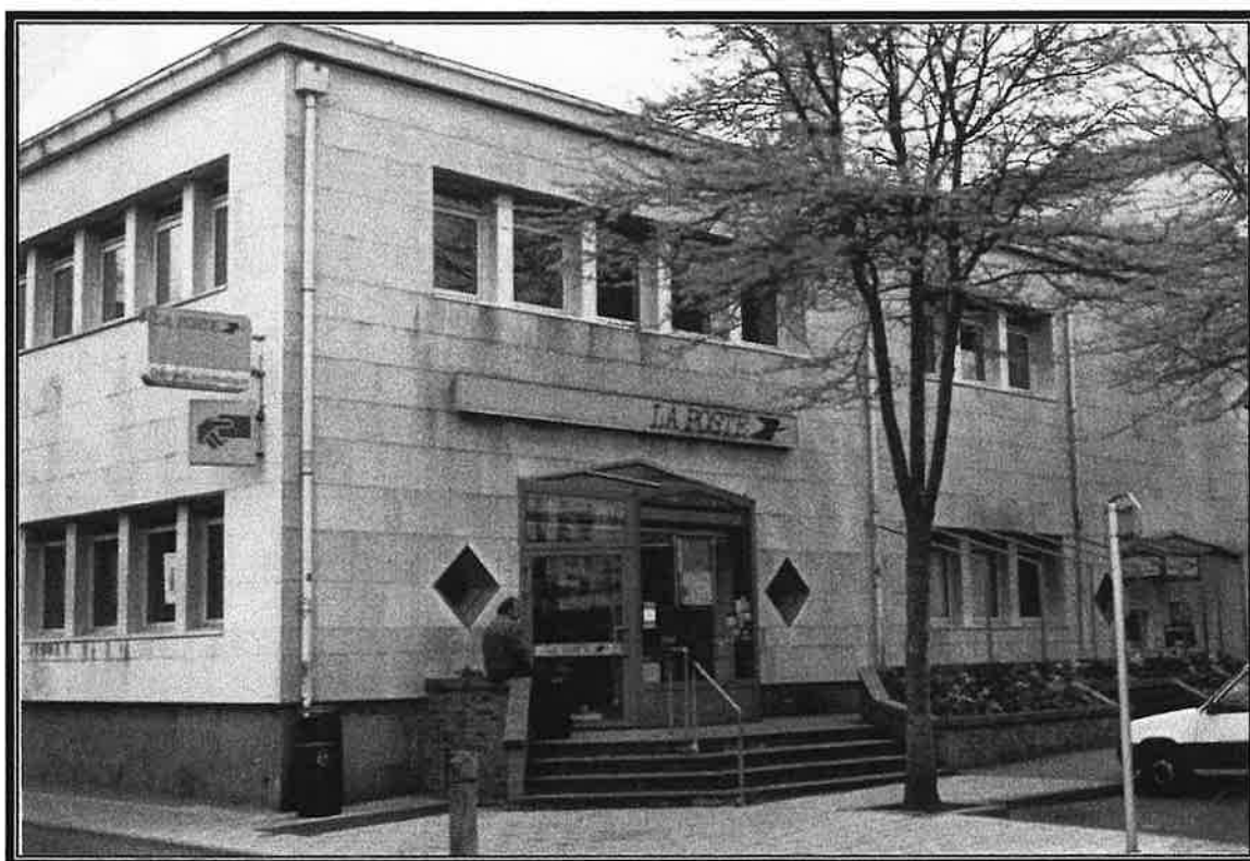
Bureau de Poste en 2001
