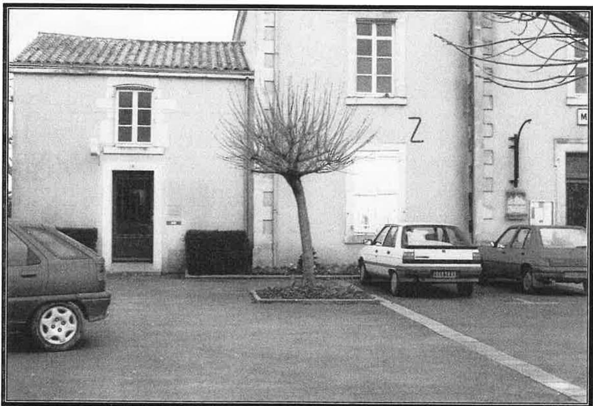
Bureau de Poste en 2001
