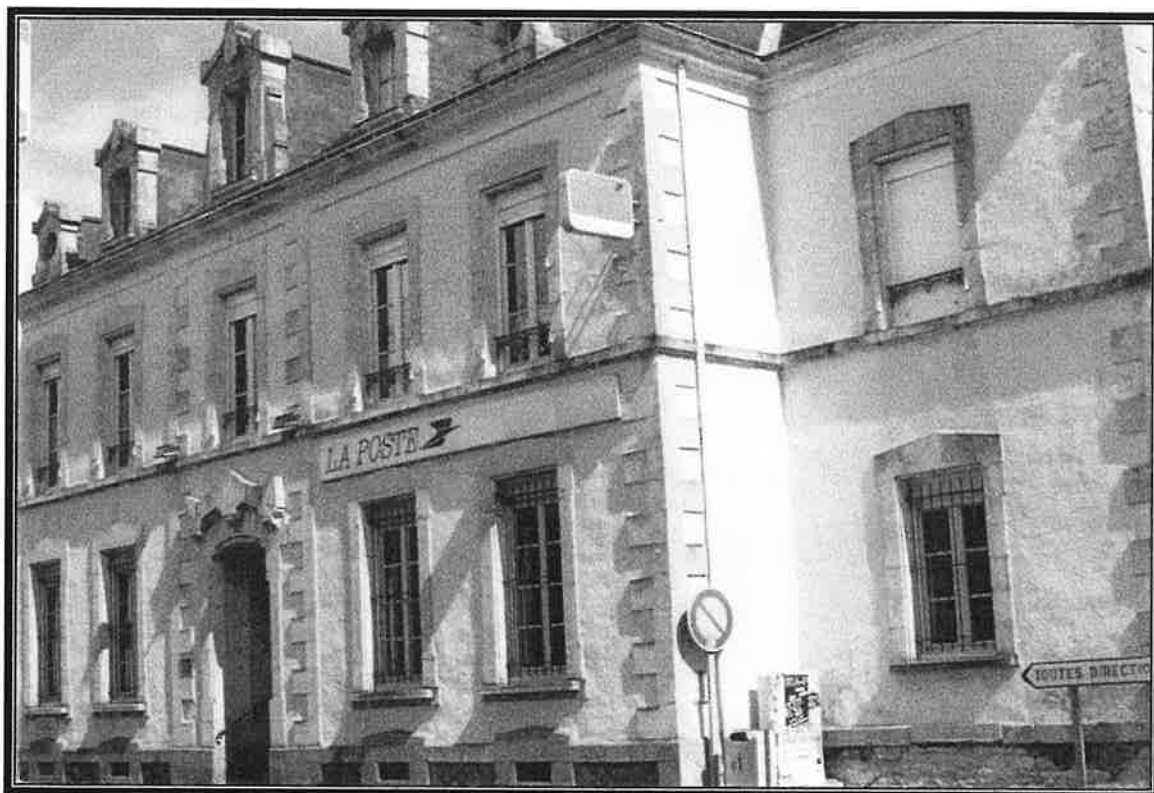
Bureau de Poste en 2001
