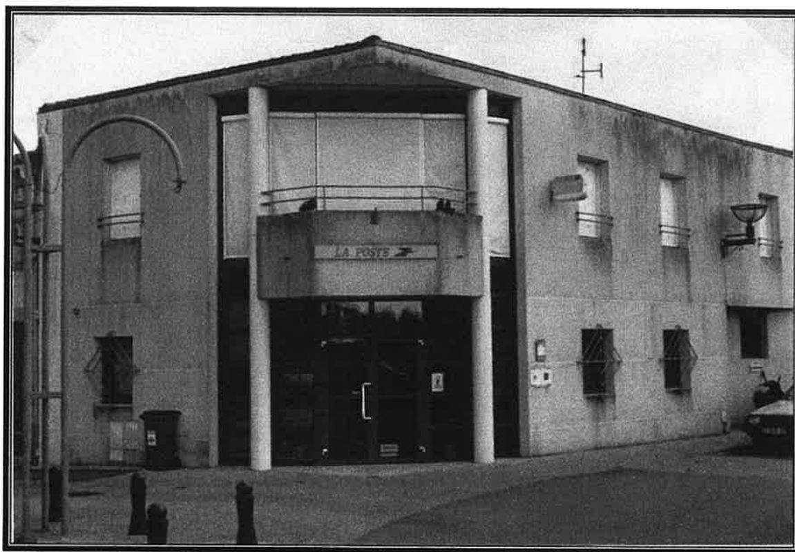
Bureau de Poste en 2001
