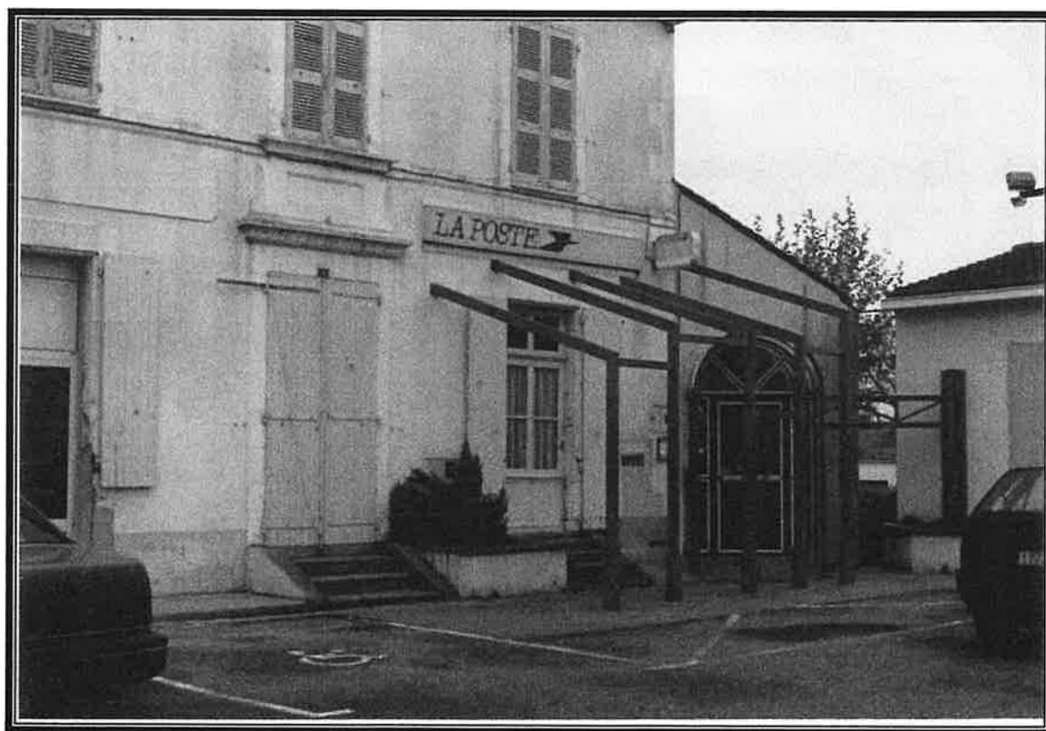
Bureau de Poste en 2001
