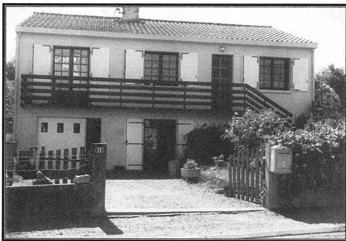
Bureau de Poste en 2001
