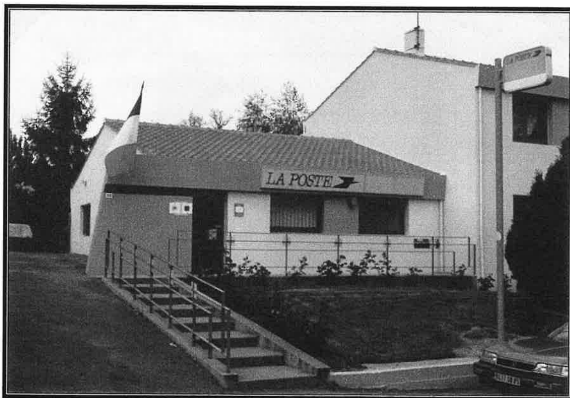
Bureau de Poste en 2001
