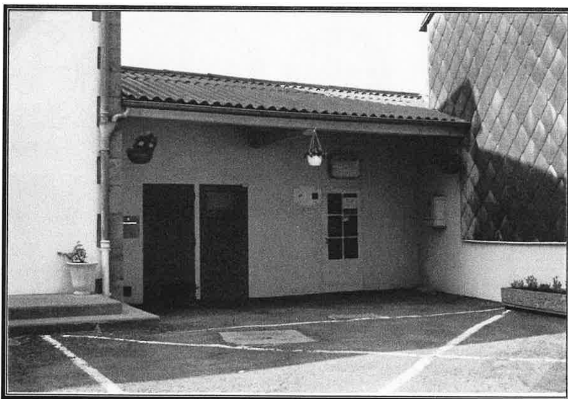
Bureau de Poste en 2001
