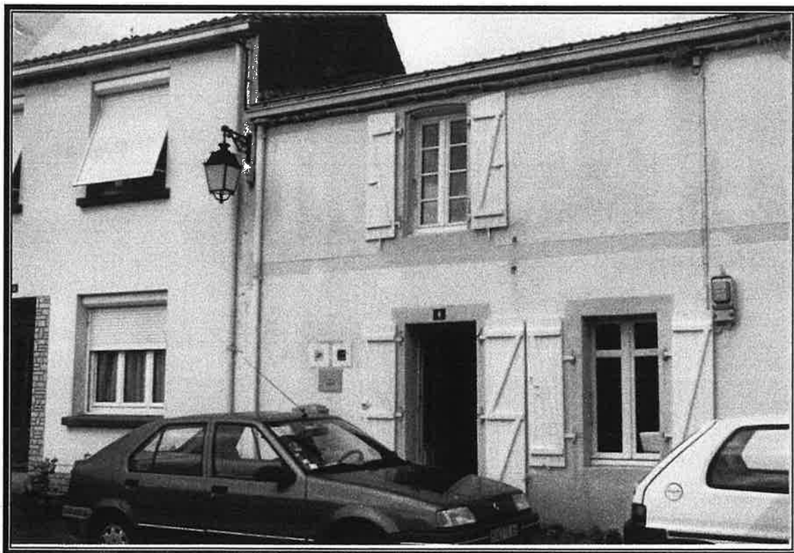
Bureau de Poste en 2001
