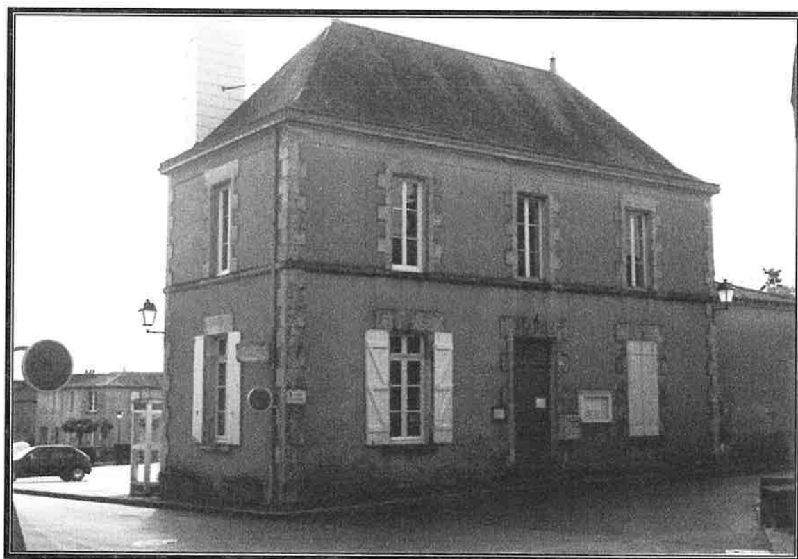
Bureau de Poste en 2001
