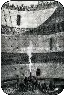
Maçonnerie du puits
