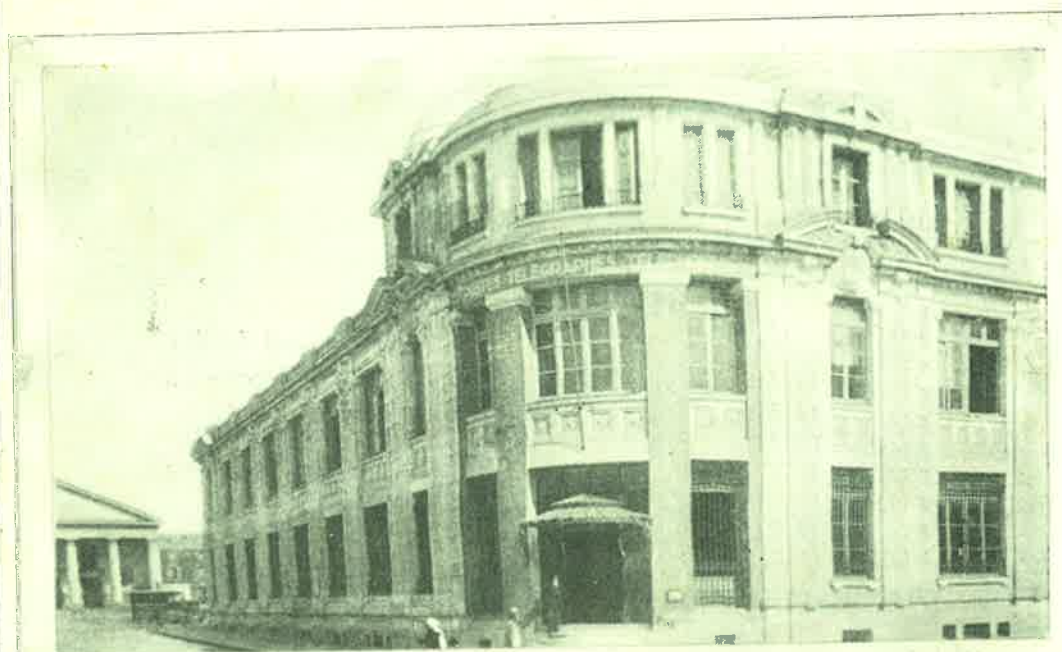
92 LA ROCHE-SUR-YON. — LA POSTE (A. BOUDAUD ET MAURICE DURAND, ARCH.) — ND
